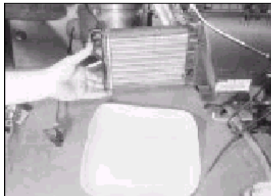
9.36b . . . pak odstraňte topné těleso . .
