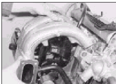
18.12c Montáž sacího potrubí
